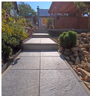
Schody z dlažby a betonového obrubníku
