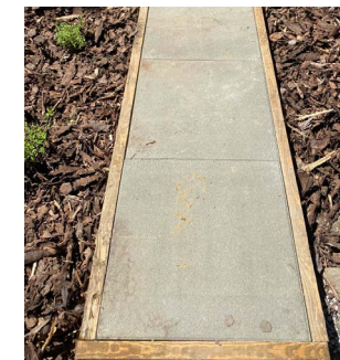
Chodníky a schody z nášlapných dlaždic v dřevěném rámu
