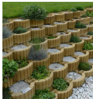
Opěrná zídka ze svahových tvárnic – osázená
