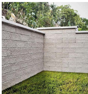
Zídka ze ztraceného bednění
