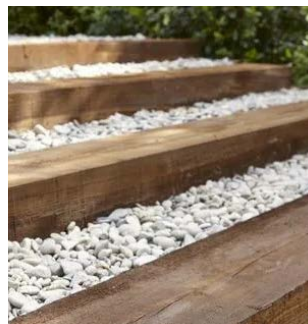
Schodiště z dřevěných trámů s nášlapnou plochou z kamínků
